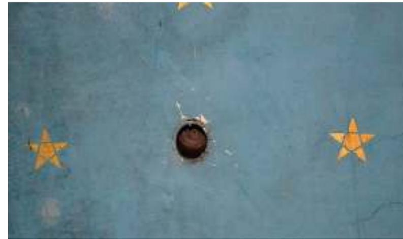
**Fig. 8:** Saint-Firmin à Vaux-en-Amiénois (Somme). Les pots prennent place dans la voûte. Seule l'embouchure des pots affleure à la surface de l'enduit dans un décor de voûte céleste parsemée d'étoiles à cinq branches.
