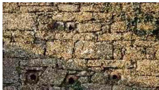
**Fig. 4:** Notre-Dame-des-Anges à Landéda (Finistère). L'analyse des maçonneries indique clairement que les pots ont été mis en place en même temps que le parement intérieur a été construit. Connaissant la date de consécration de l'église (1507), on peut ainsi dater les pots, dont la typologie céramique locale est mal documentée à ce jour.
